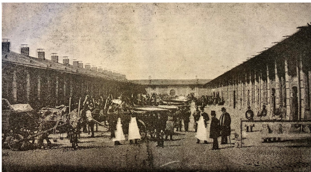
Рис. 2. Санкт-Петербургские городские скотобойни. Центральный двор с убойными камерами
